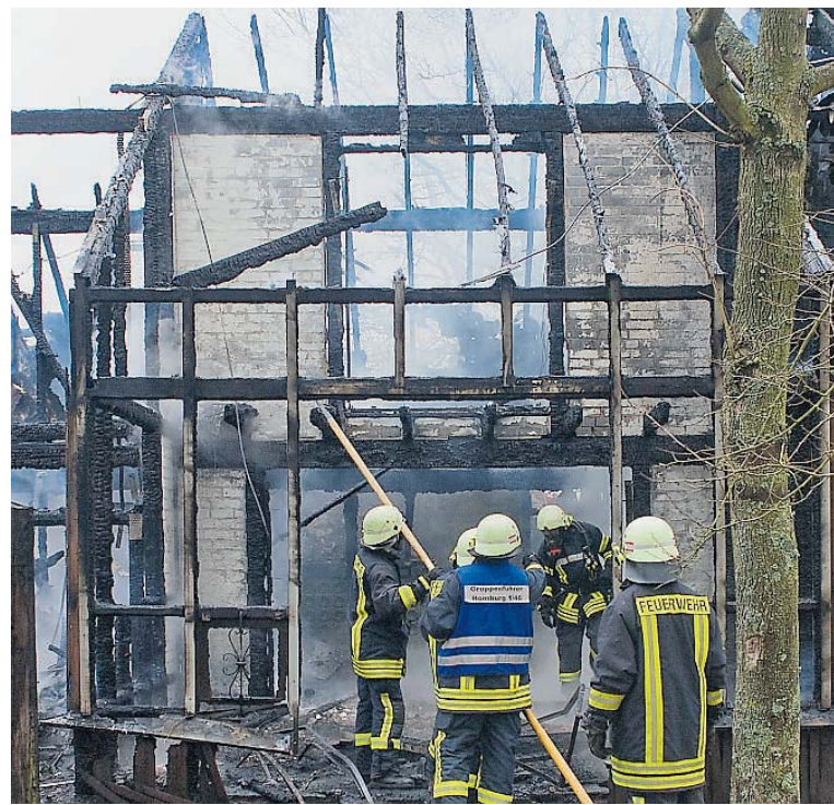
Der Brand zerstörte das KSJ-Haus vollständig, nur Reste des Baus am Homburger Johanneum blieben stehen.
